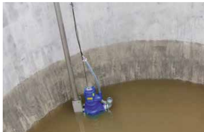
Förderung der aufbereiteten Gülle zum speziellen Pressschneckenseparator
